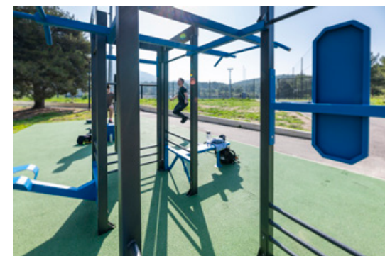
Installation extérieure connectée de fitness
